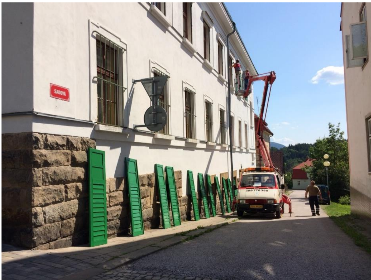
Instalace renovovaných okenic 25. 5. 2018
