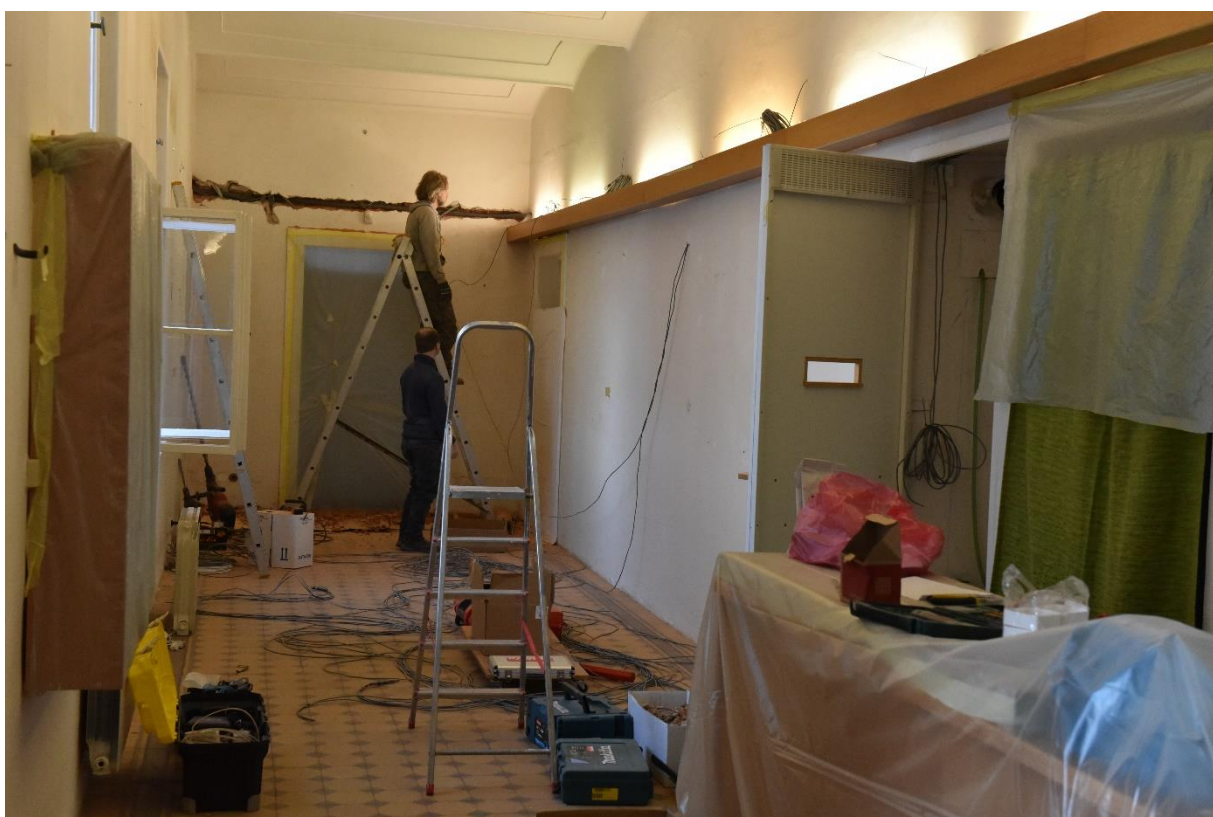
Rekonstrukce elektrorozvodů, telefonního a internetového vedení
