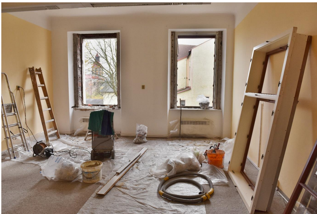
Výměna oken v budově muzea čp. 10
