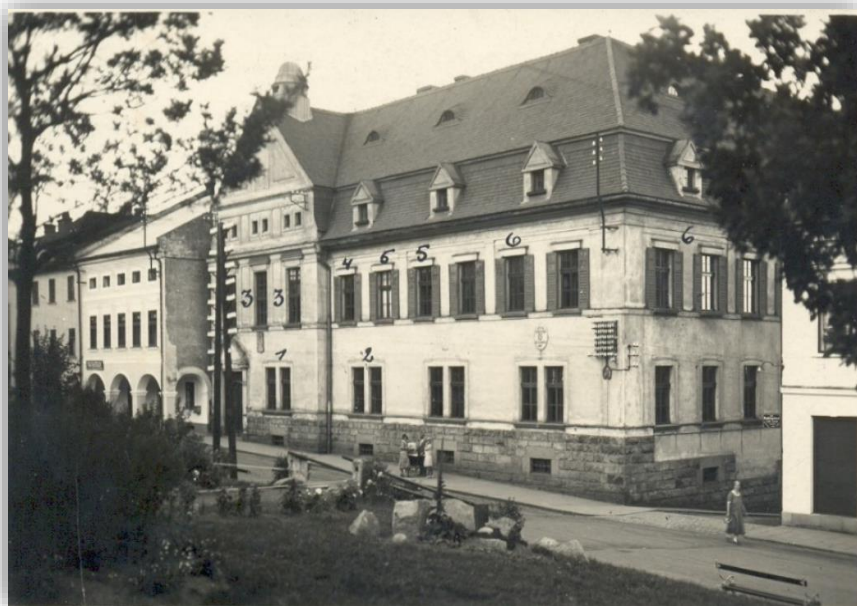
Budova okresního soudu 1. pol. 20. st.
